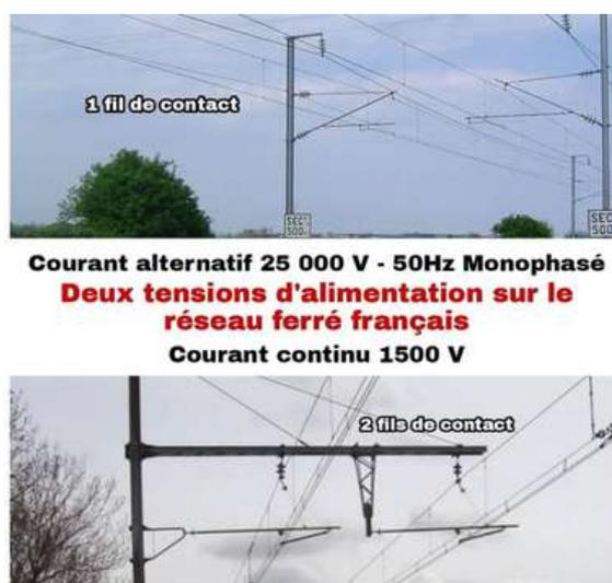
**Fig. 2 - Illustration des différents types d'électrification du RFN.**
